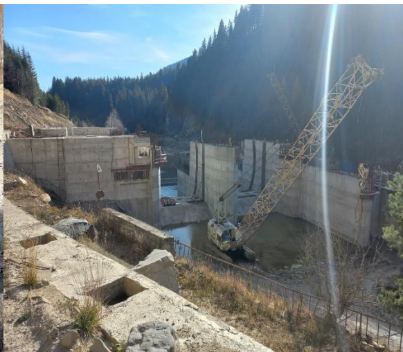
Foto nr. 2 – Vedere din amonte Baraj stăvilar Surduc
