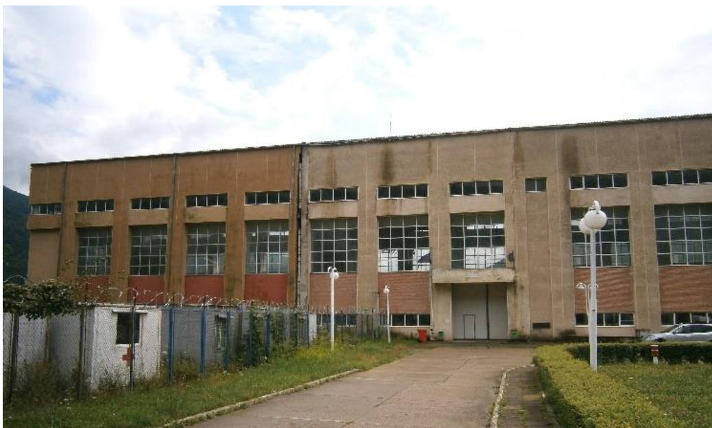
Foto nr. 8 – Clădire CHE Nehoiașu
