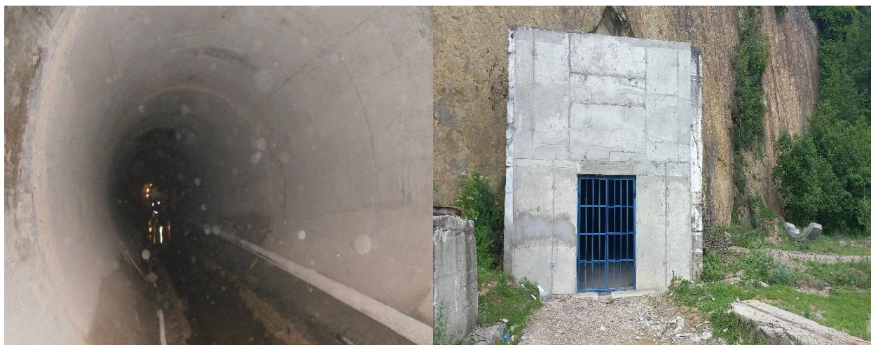
Foto nr. 5 – Galeria de aducțiune – interior
