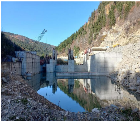
Foto nr. 1 – Vedere din aval
