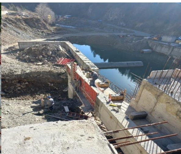
Foto nr. 4 – Scară de pești-cofrare
