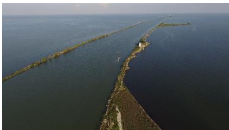
Figura II.1.3.1. Digurile de protecție a canalului Sulina
