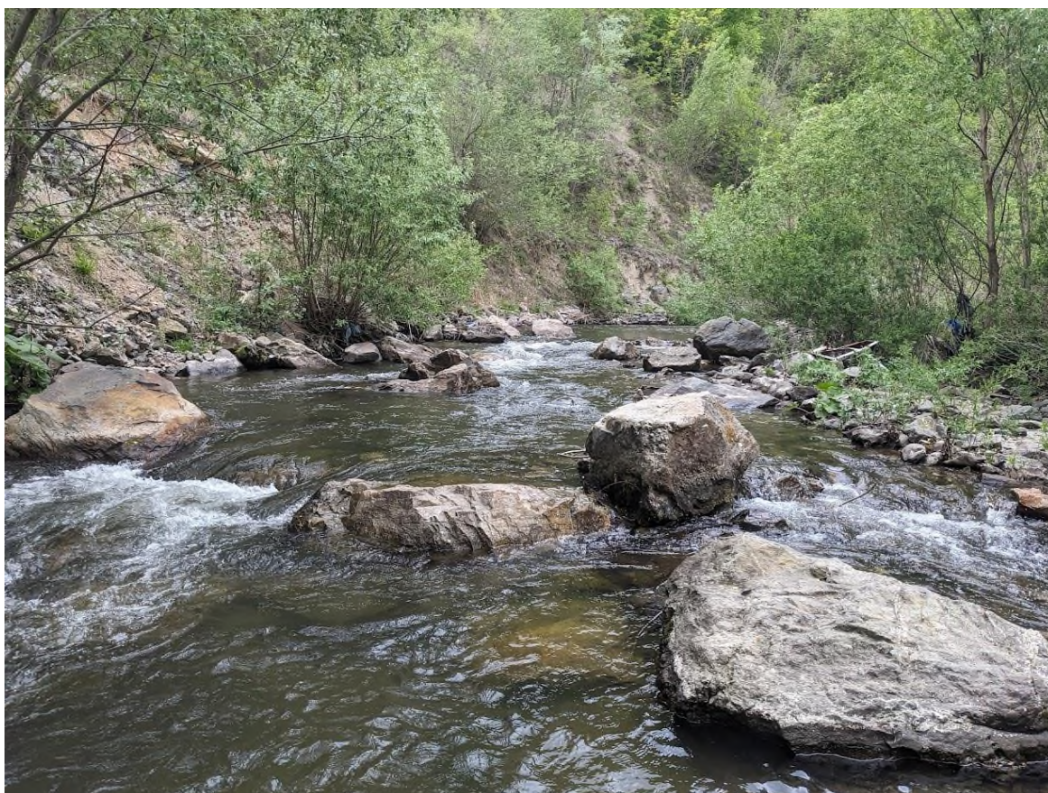
Fig. 141 Sectorul Cornereva Zonă regularizare aval baraj
