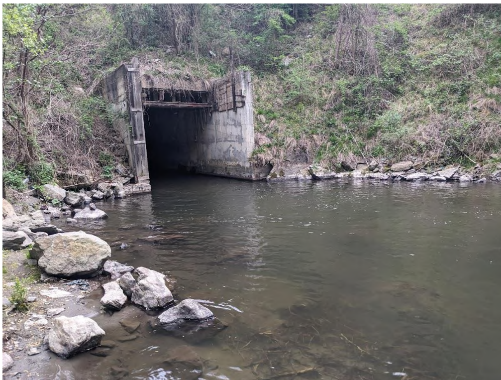
Fig. 156 Evacuarea apei râului Belareca aval baraj Cornereva
