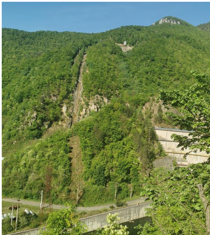
Fig. 68 – Extinderea castelului de echilibru, nodului de presiune și conductei forțate pe versantul drept al Cernei
