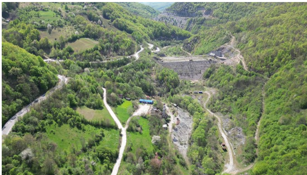
Fig. 25 – Imagine aeriană cu extremitatea aval a viitorului lac de acumulare Cornereva
