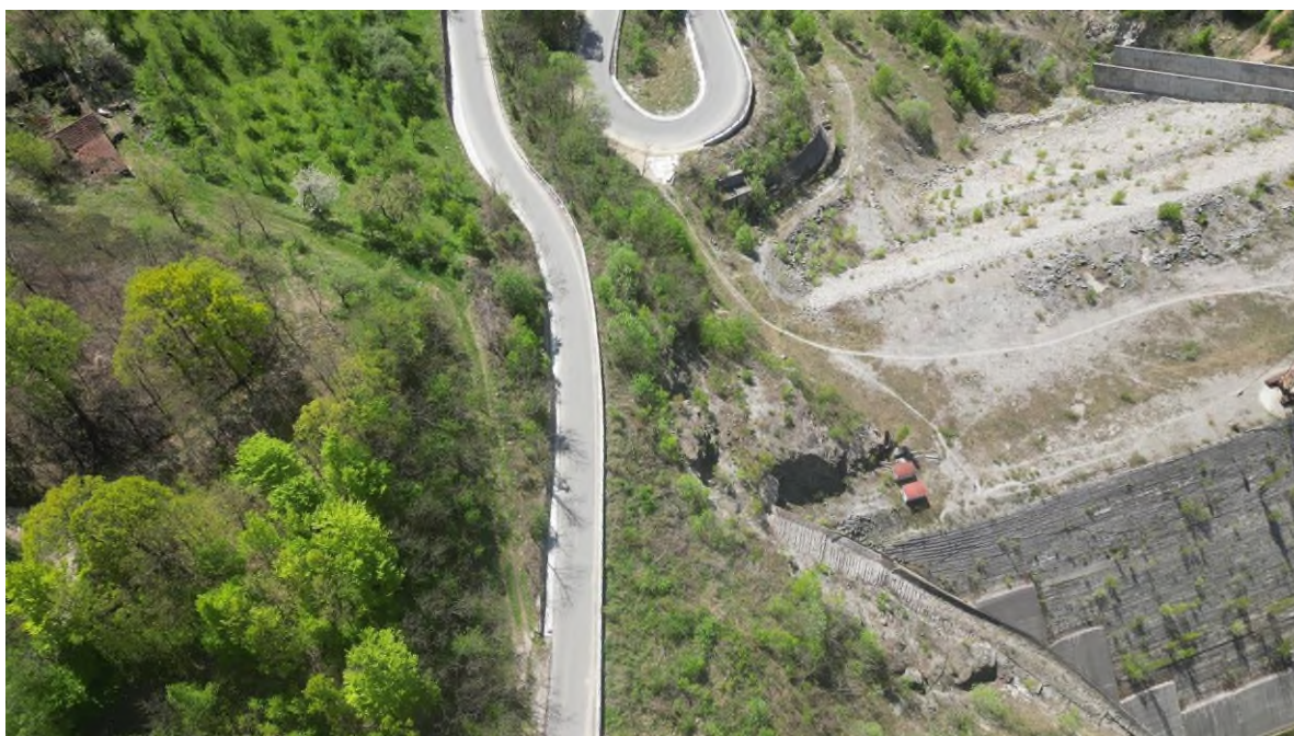
Fig. 33 – Imagine aeriană cu flancul stâng al barajului Cornereva, acolo unde este ancorat în versantul corespondent, în conglomeratele cuarțitice ale Formațiunii de Gresten. Vegetația de aici, pionieră, nu este considerată a reprezenta habitate N2000
