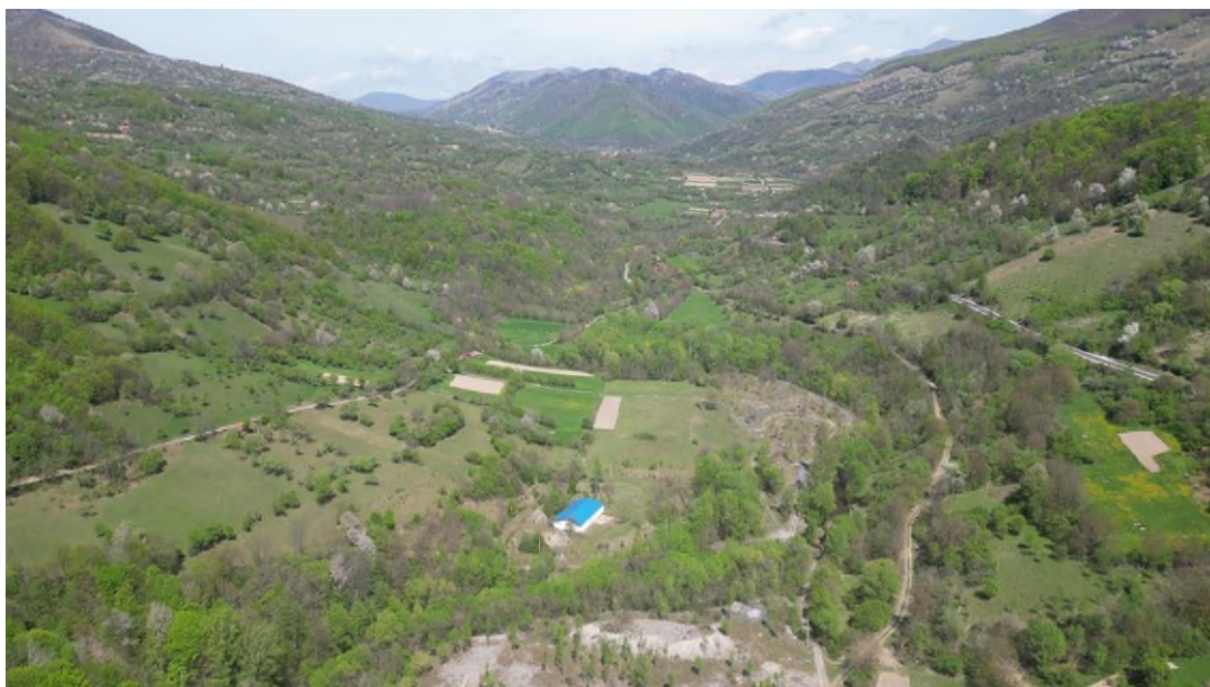
Fig. 28 – Imagine aeriană spre amonte cu partea mediană a cuvetei viitorului lac de acumulare Cornereva.
