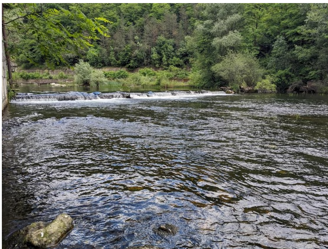
Fig. 144 Sectorul Cerna proximitate Hidrocentrala Herculane
