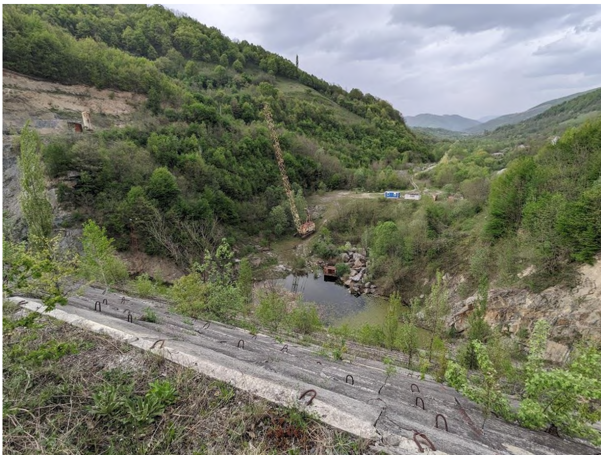
Fig. 155 Barajul Cornereva – vedere în amonte
