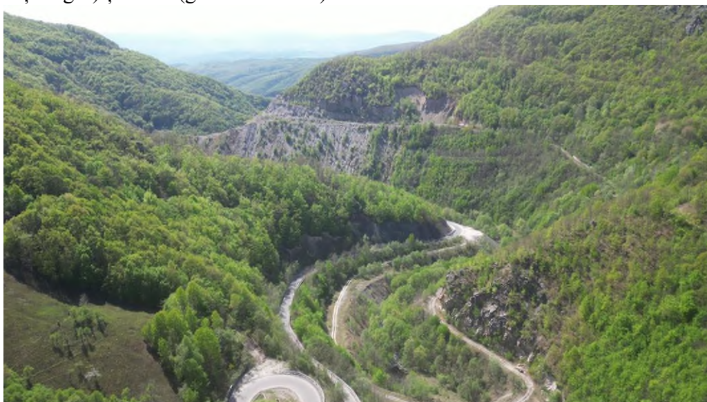
Fig. 18 – Imagine aeriană cu porțiunea aval a văii Belareca față de baraj, cu numeroase prelucrări ale versanților văii, din anii 80 ai secolului trecut
