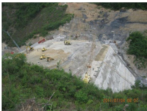
Depuneri de anrocamente și filtre în corpul barajului – iulie 2011
