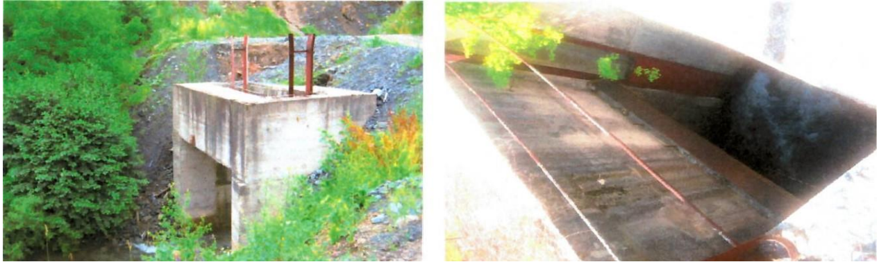
Figura 8 - Baraj Cornereva. Portalul galeriei de deviere
