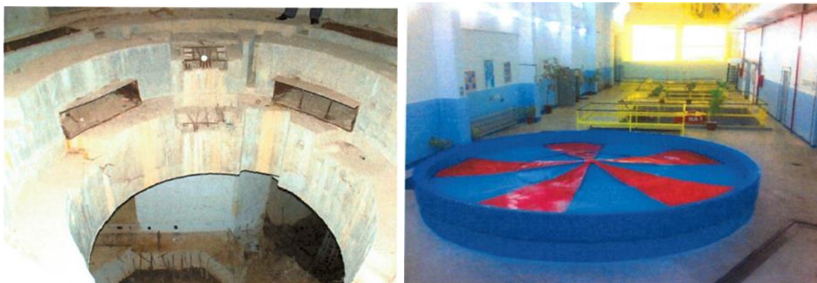
Figura 11 - CHE Herculane. Locul de montaj al HA3
