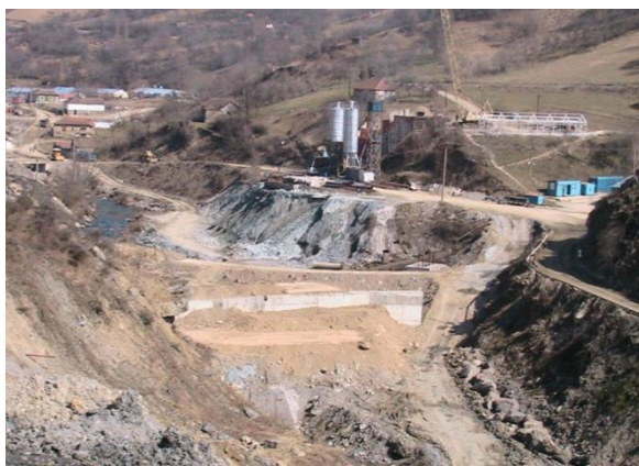
Figura 7 - Batardou amonte. Vedere din timpul execuției – martie 2007
