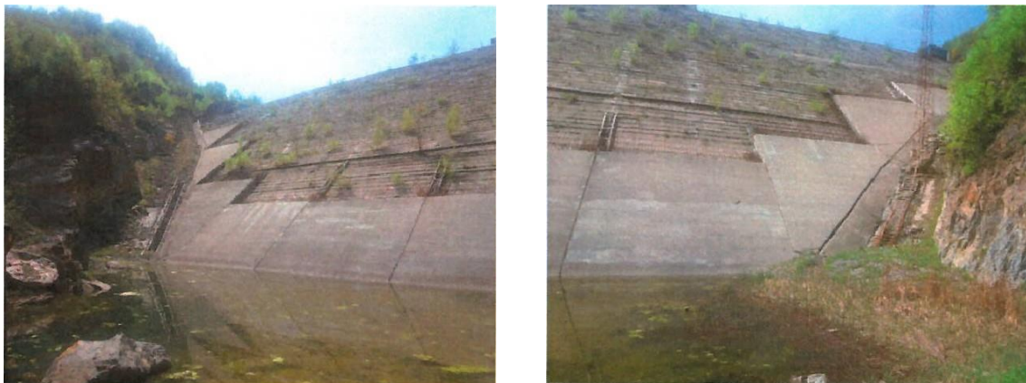
Figura 4 - Masca de beton baraj Cornereva
