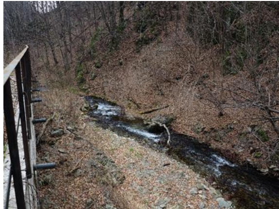
Zona aval de captare
