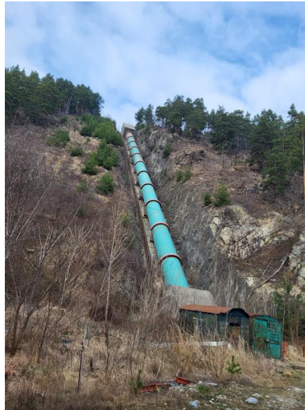
Figura 8 Conducta forțată nod hidrotehnic Bumbești
