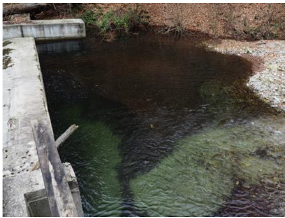
Zona barajului deversor
