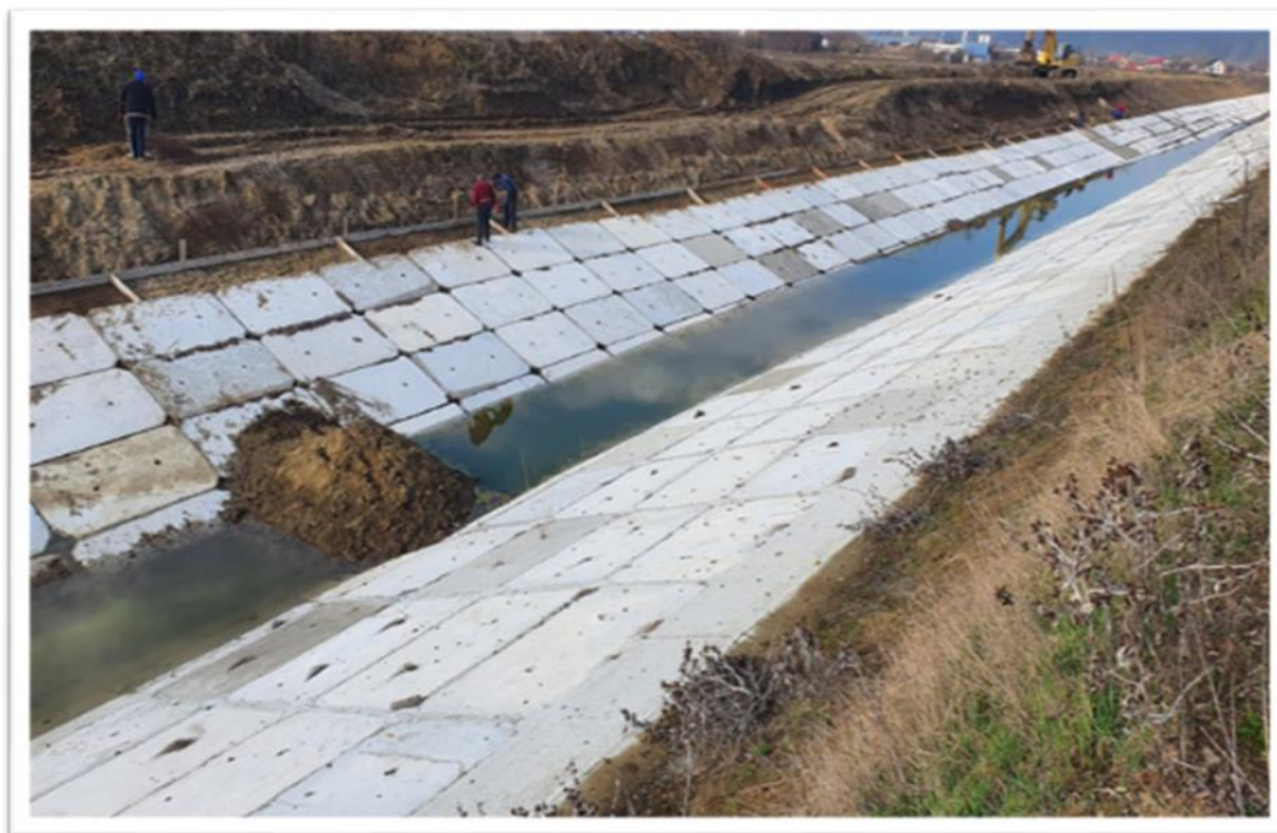
Figură 5. Aspect din teren privind canalul colector realizat
