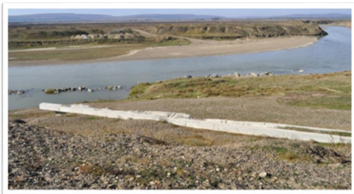
Figură 6. Aspect din teren privind lucrările localizate pe malul stâng
