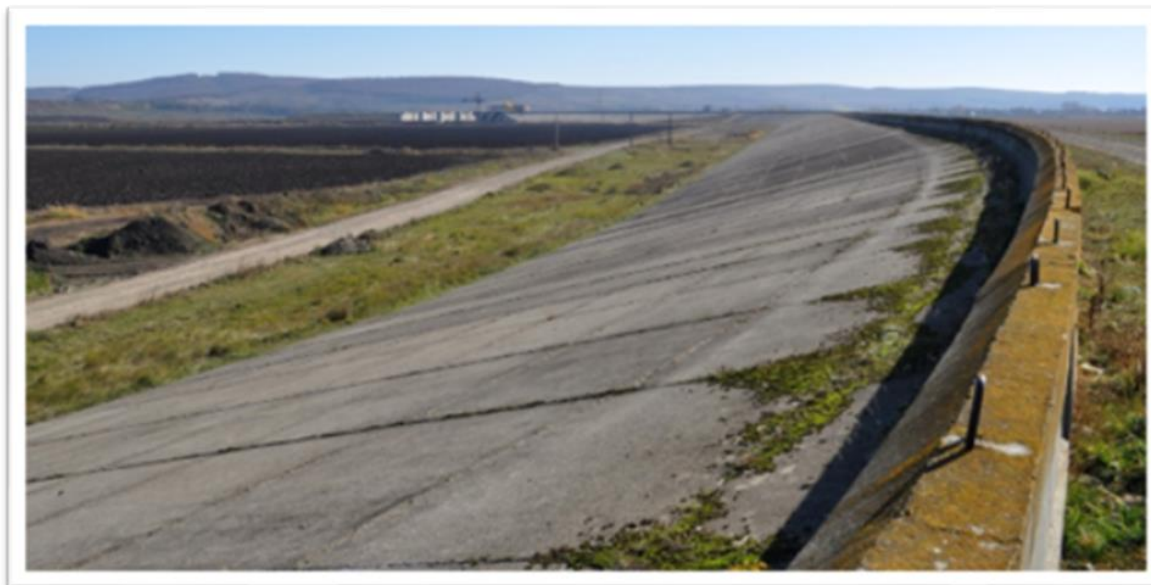
Figură 4. Aspect din teren privind digul realizat
