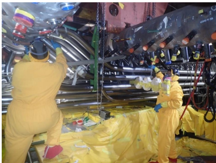
Fig. 11 Instalare fideri superiori
