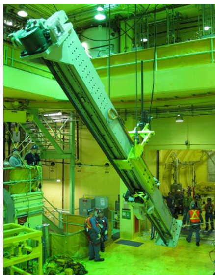
Fig. 9 Platforma pentru demontarea canalelor de combustibil
