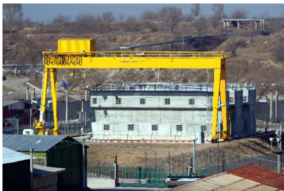
Fig. 6 Depozitul intermediar de combustibil ars
