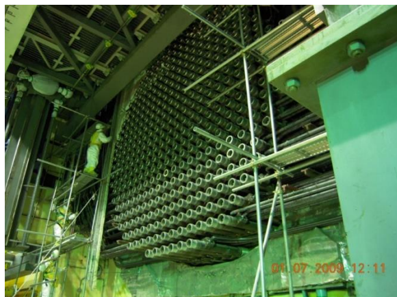
Fig. 8 Demontare feederi
