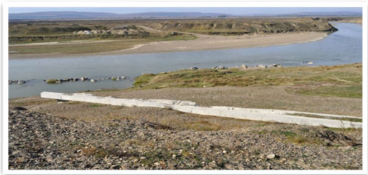
Figura 3. Dig mal stâng, lucrări finalizate
