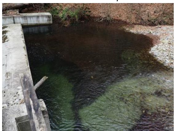
Zona barajului deversor
