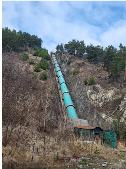
Figura 8 Conducta forțată nod hidrotehnic Bumbești
