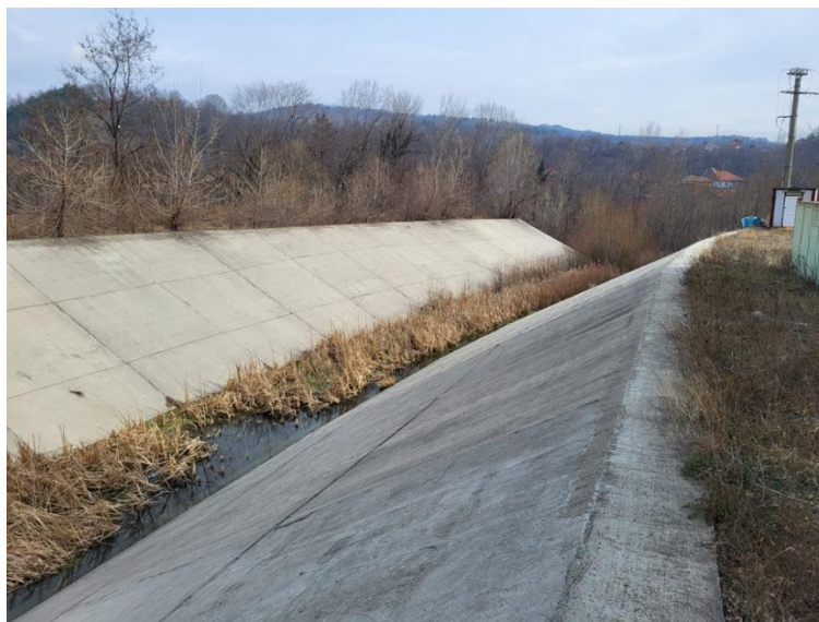
Figura 12 - Canalul de fugă la racordul cu bazinul de liniștire
