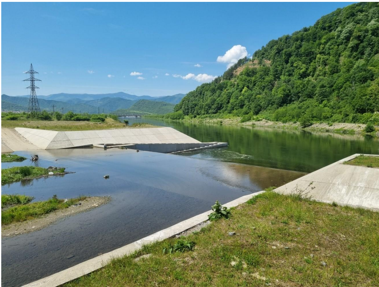
Foto nr. 57 Amenajarea debrușării râului Șebeș
