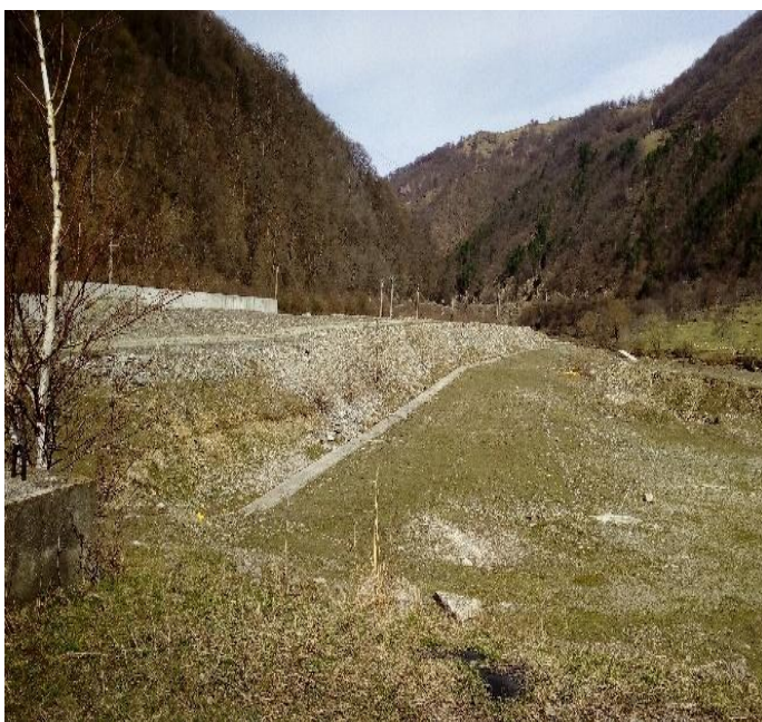
Foto nr. 9 - CHE Căineni - dig mal drept- zona de racord cu centrala – ecran tip Kelly executat și umpluturi în corp dig pe cca. 1,0 m înălțime
