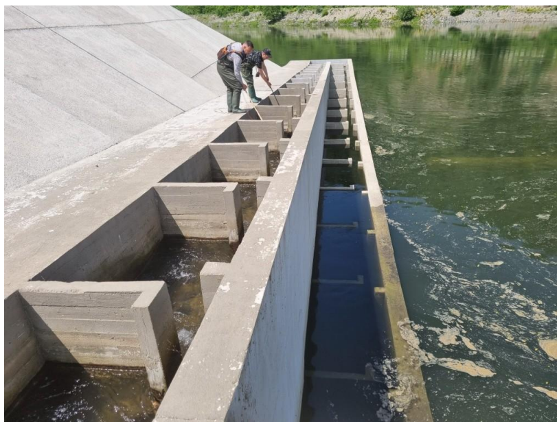
Foto nr. 60 Scară de pești existentă
