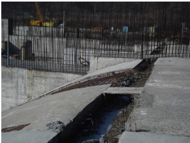
Foto nr. 3 – CHE Câineni - vedere din amonte spre aval – deschiderea nr. 3 unde a rămas nebetonat profilul deversant pe o fâșie de 4 m lățime
