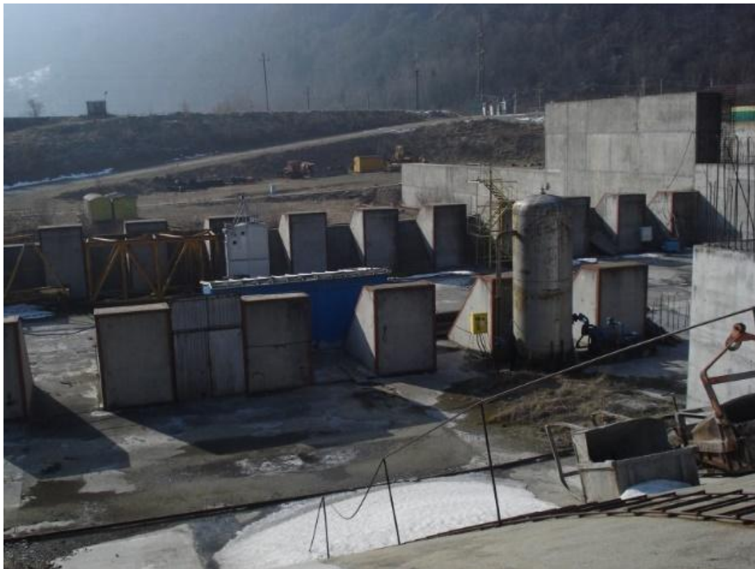
Foto nr. 4 – CHE Căineni - disipatorul de energie – vedere de pe creasta descărcătorului
