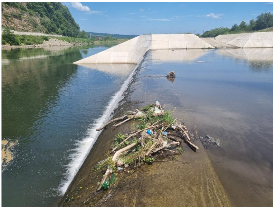
Foto nr. 59 Coronament deversor la debușarea pr. Șebeș
