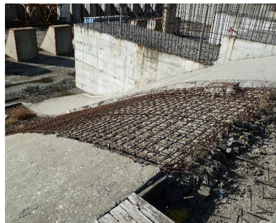
Foto nr. 3 – CHE Câineni - vedere din amonte spre aval – deschiderea nr. 3 unde a rămas nebetonat profilul deversant pe o fâșie de 4 m lățime
