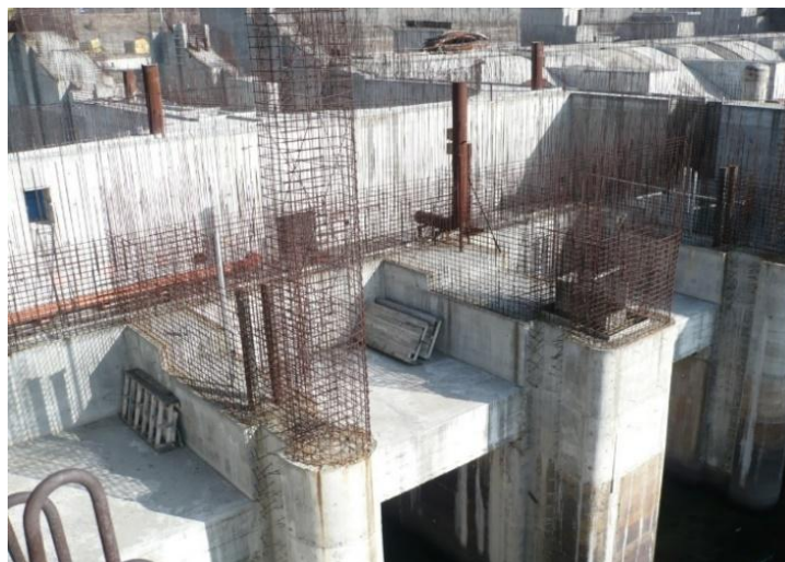
Foto nr. 12 – CHE Căineni - centrala– zona pile aval
