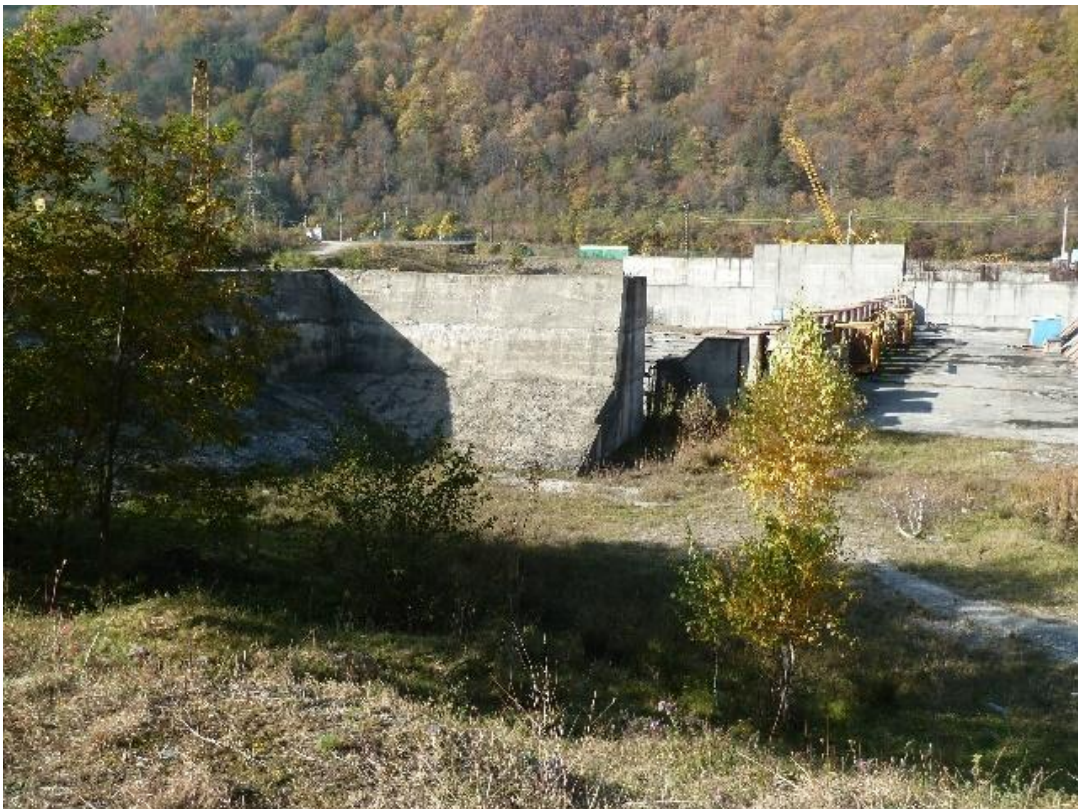
Foto nr. 6 - CHE Câineni - două tronsoane de zid aval executate până la cota 339,50 mdMB
