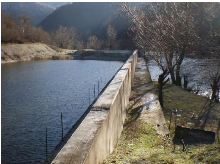
Foto nr. 18 - CHE Lotrioara - pila despărțitoare poziționată pe mijlocul barajului devensor
