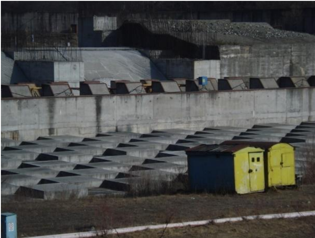
Foto nr. 5 – CHE Câineni - rizberma fixă executată la cotă finală
