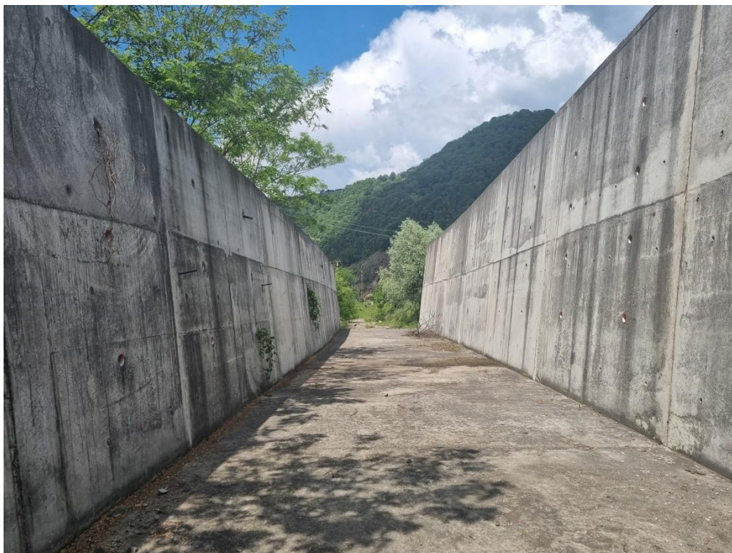
Foto nr. 65 Tronson existent cuvă beton
