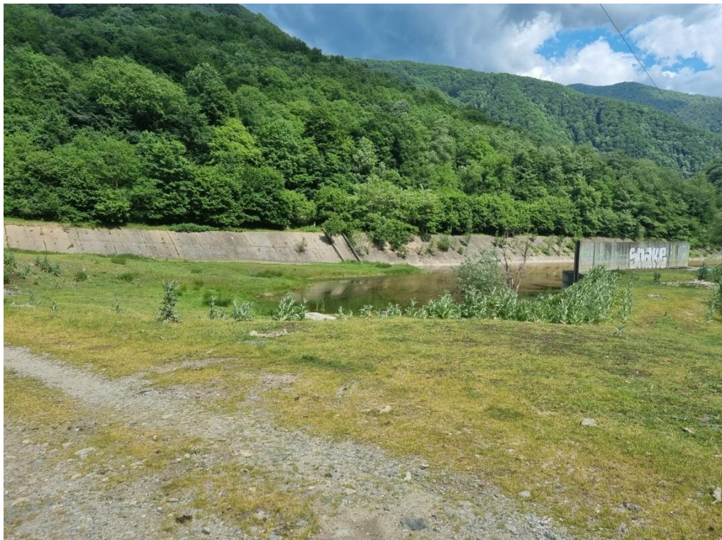
Foto nr. 62 Amplasament CHE Lotrioara, mal stâng
