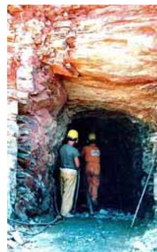
Escavări la galeria artificială de la Alqueva.
