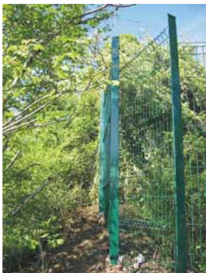
Gard de siguranță, Franța
