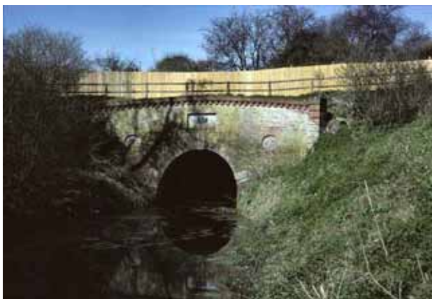
Grilaj la canalul tunelului Greywell.
