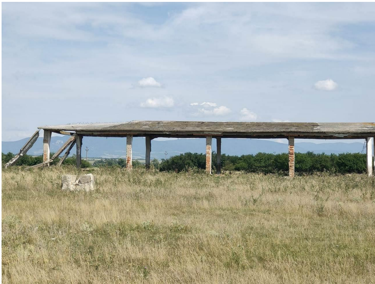
Fotografia 68: Clădire abandonată potențial optimă pentru specii de crăpătură – Potoc 3
