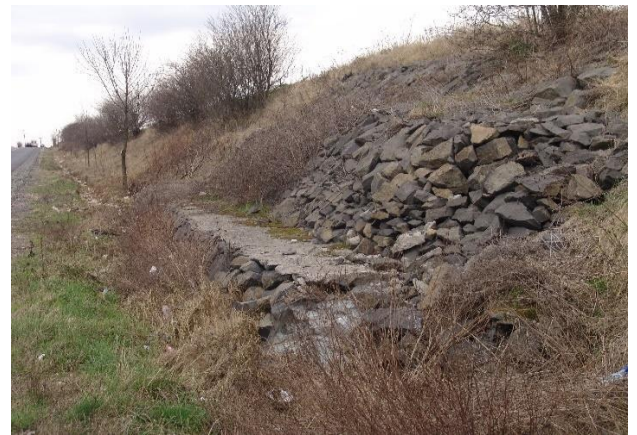
Figura 94. Utilizarea de bolovănișuri ca microhabitate este în măsură a oferi nișe suplimentare ecologice (stânga) și funcționând ca zone de drenaj a apelor de spălare ce contribuie substanțial la stabilizarea pantelor (dreapta)
