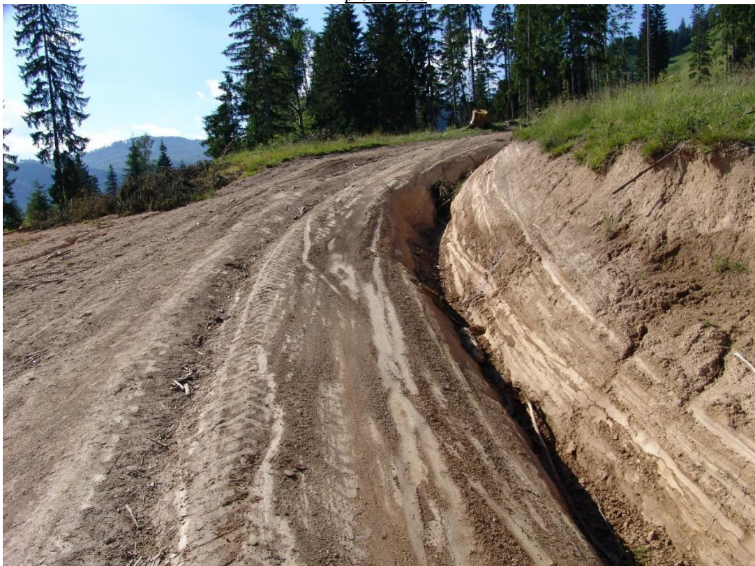
Figura 24. Ilustrarea impactului asociat unui drum forestier de exploatare; se observă ogașele profunde cauzate de fenomenele erozive, tasările generate de târârea arborilor și zonele extinse de afectare ca urmare a insuficientei pregătire a zonelor de schimbare a direcției
