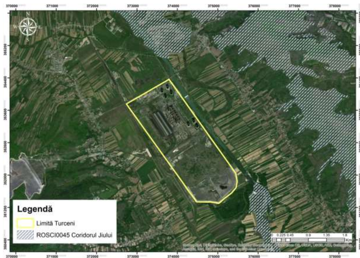
Figura 36 Localizarea obiectivului "Realizarea unui grup energetic nou de 400 MW parametri ultrasupracritici la Turceni"
