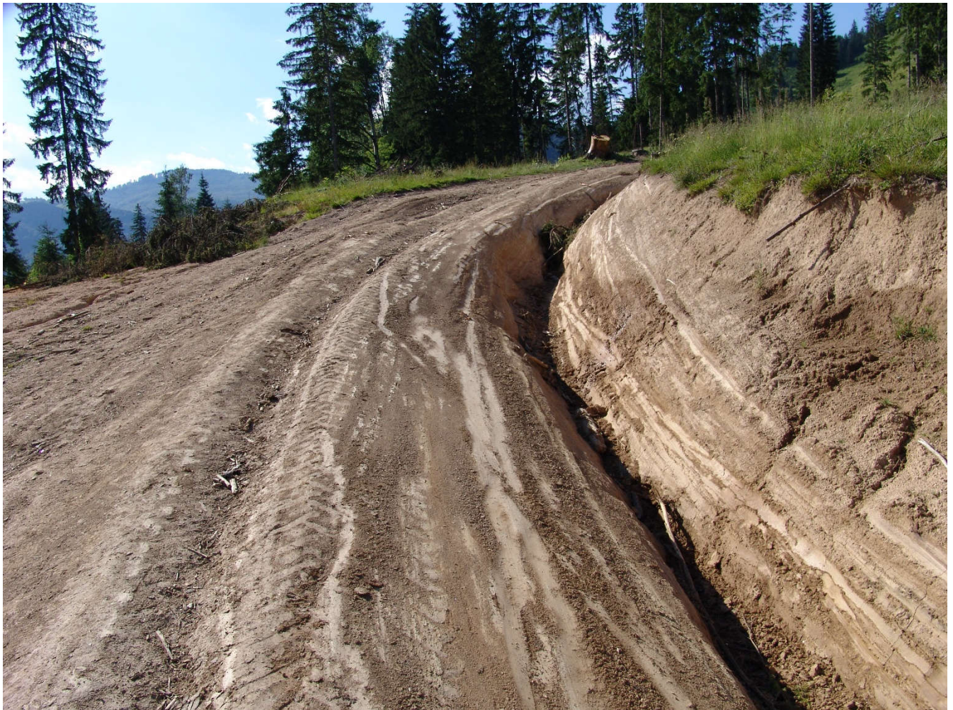
Figura 4. Ilustrarea impactului asociat unui drum forestier de exploatare; se observă ogașele profunde cauzate de fenomenele erozive, tasările generate de târârea arborilor și zonele extinse de afectare ca urmare a insuficienței pregătire a zonelor de schimbare a direcției
