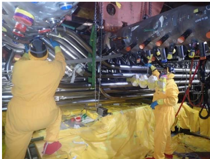
Figura 10 - Instalare fideri superiori [7]
