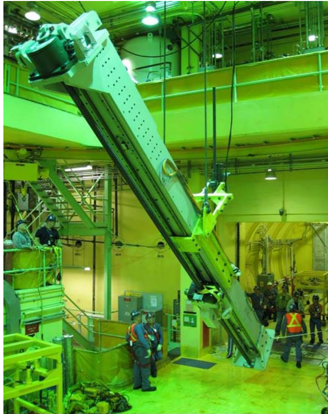
Figura 8 - Platforma pentru demontarea canalelor de combustibil [7]
