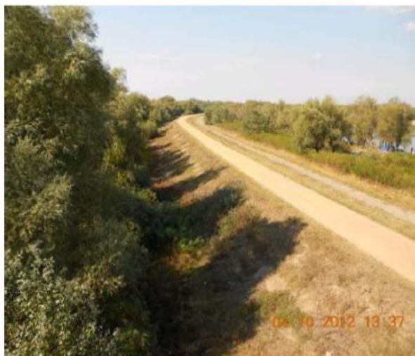
Digul de mijloc al canalului de alimentare
