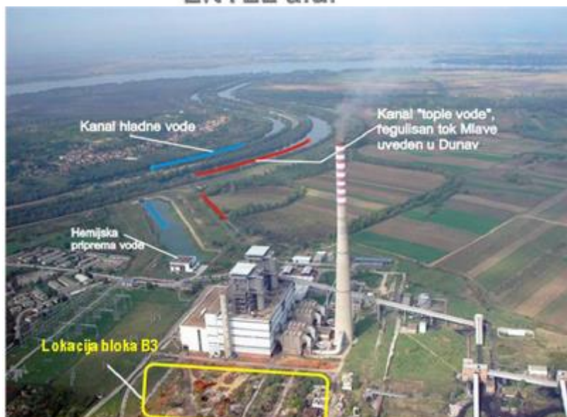
Figura 3.3.3-1: Centrala termoelectrică Kostolac B inclusiv amplasamentul pentru construirea unității B3
