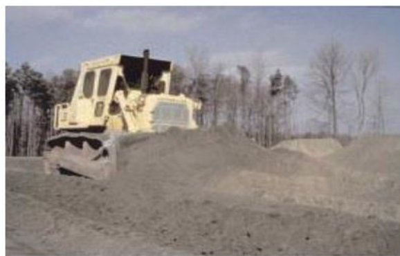
Figura 3.3.4-13: Buldozere care lucrează la distribuție și planificare
