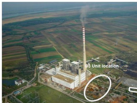
Centrala termică Kostolac B
