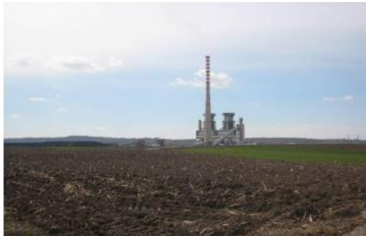
Figura 2.13-2: Peisajul zonei înconjurătoare mai apropiate din jurul centralei termoelectrice Kostolac B
