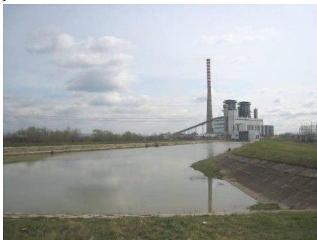
Figura 2.5-6: Canalul de apă rece
