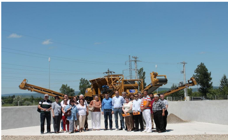
Figura 3. Proiect pilot – Instalație de tratare mecanică a deșeurilor din construcții și demolări – LIFE 10 ENV/RO/000727 (sursa: http://life-dcd.ro )
