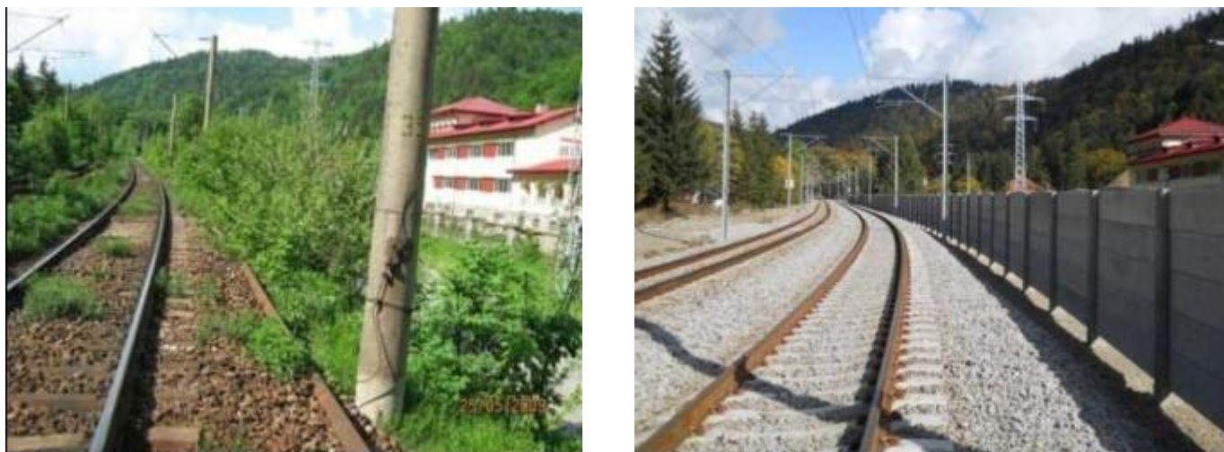
Figura 5.16 Exemplu de linie de cale ferată înainte și după reabilitare
