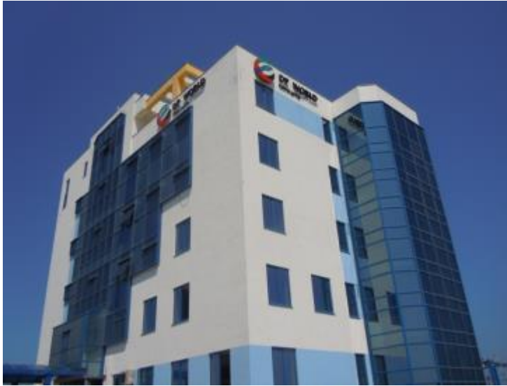
Figura 8.1 Sediul DP World în terminalul Constanța Sud (CSCT)
