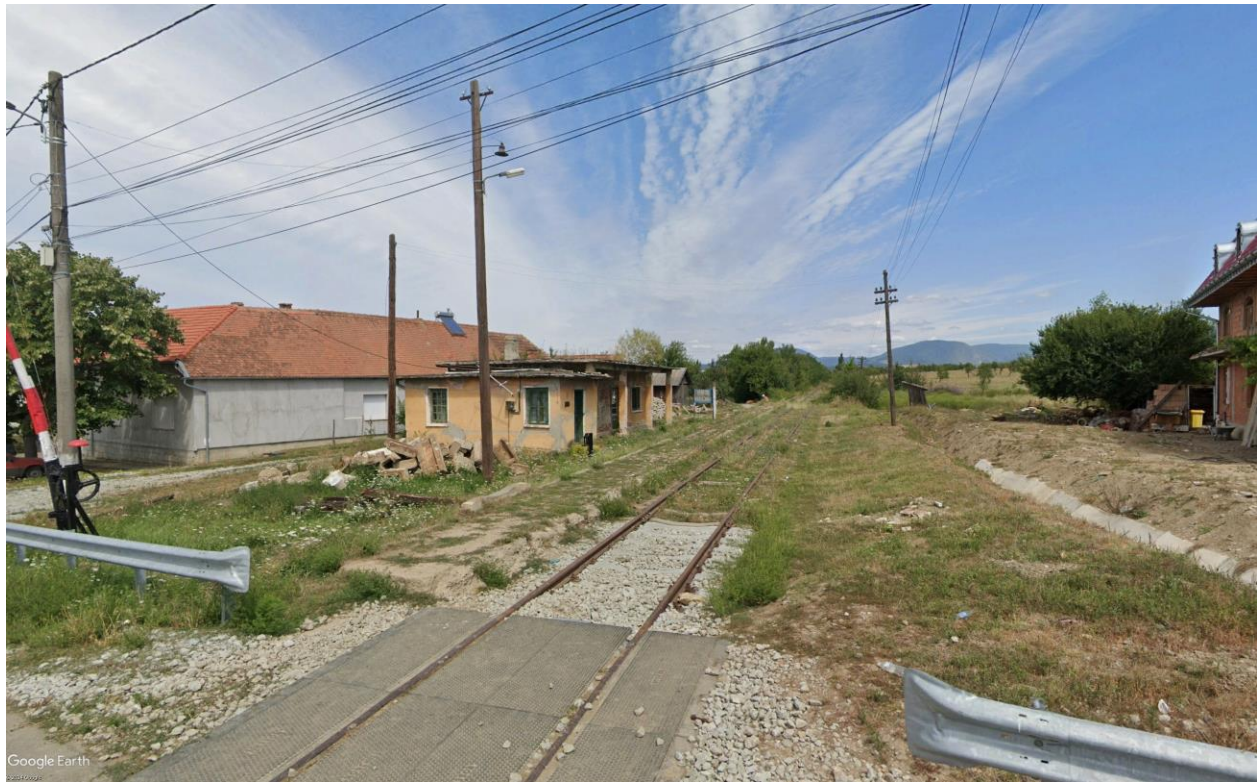
Fig. 52 Peisaj industrial în zona proiectului Potoc 1, Halta CFR Răcășdia
