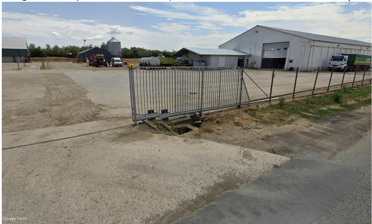
Fig. 53 Peisaj industrial în zona proiectului Potoc 1, Depozit Răcășdia
